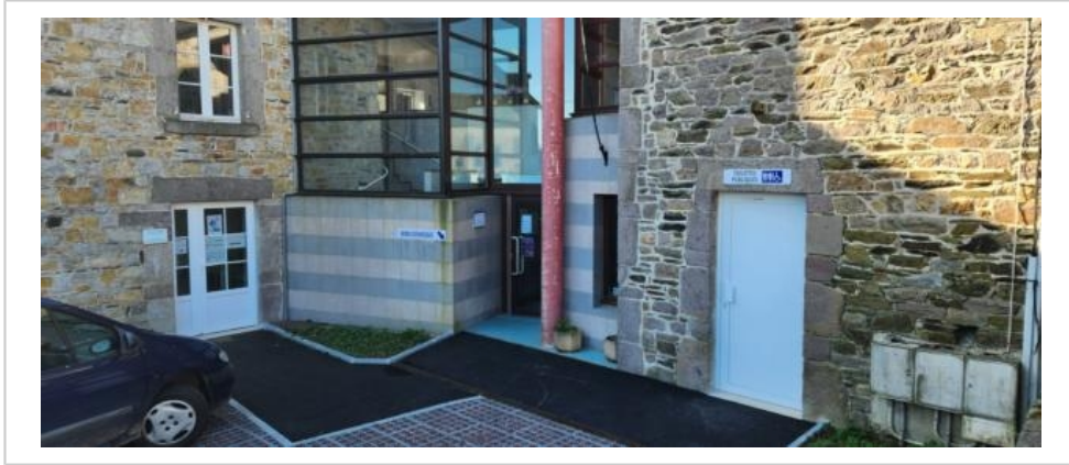
La cour de la mairie a été rénovée et de nouvelles toilettes publiques ont été ouvertes à côté de la bibliothèque. © Bruno LACOTTE
