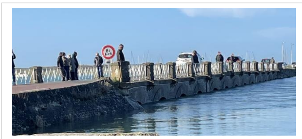
On ne distinguait plus les 13 arches du pont. © Judith LACOURS
