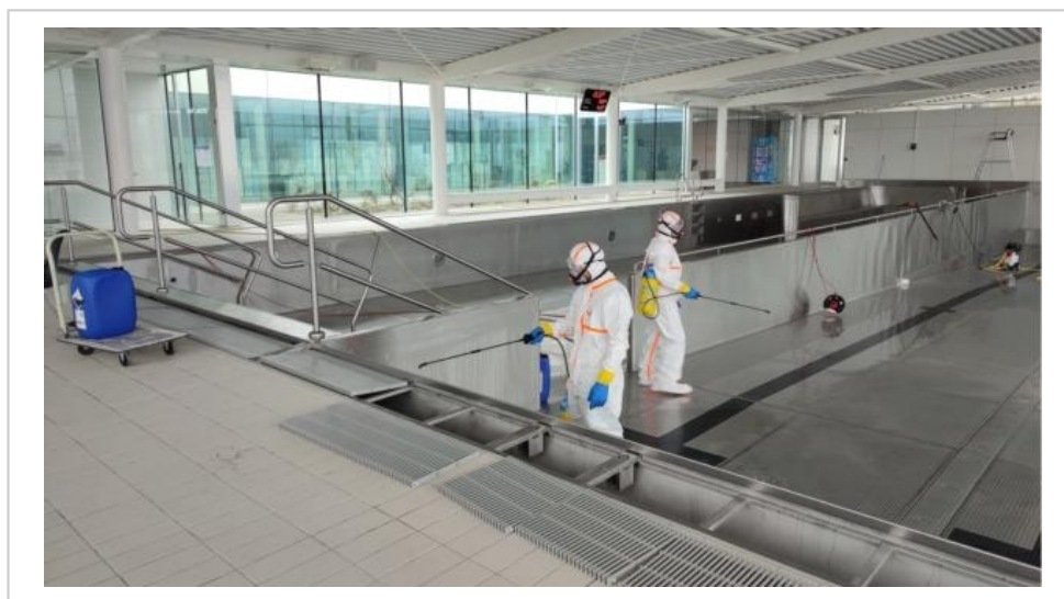
Les agents sont équipés spécifiquement pour le nettoyage à haute pression sur le revêtement inox des bassins. © Ouest-France
