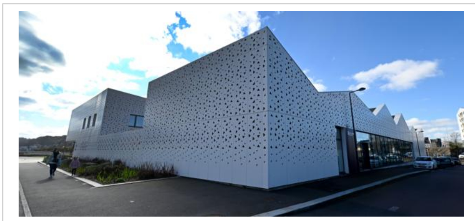
La crèche Agnès-Varda, construite dans le quartier des Bassins à Cherbourg-en-Cotentin, est fermée depuis le 14 juin 2024 à cause de malfaçons. © Jean-Paul BARBIER
