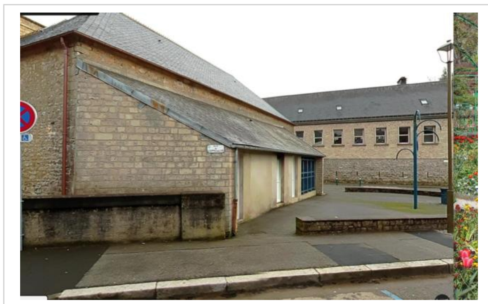
Les sanitaires publics au croisement des rues Pelouze et de l'Officialité vont être démolis dans le cadre du réaménagement du quartier. © Corinne GALLIER
