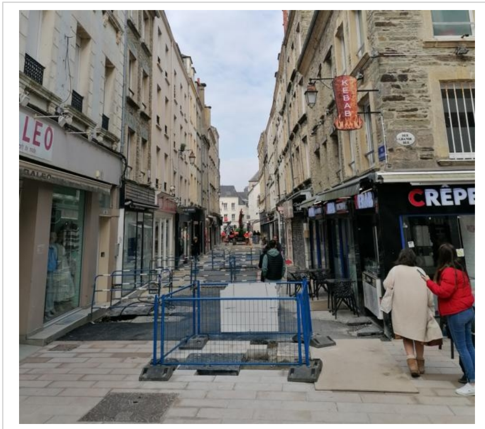
C'est principalement la rue du Commerce qui est en cours de rénovation en ce moment. Le grand chantier du plateau piétonnier se terminera par la rue des Portes et la place de Verdun en novembre prochain. © Jean-Philippe MASSIEU
