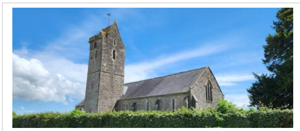
La toiture de l'église va être rénovée. © Bruno Lacotte
