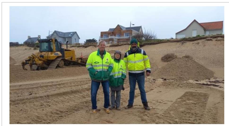
Guy Leprevost, Florence Perrot et Jérôme devant les travaux de chargement de sable à Barneville-Plage et Saint-Jean-de-la-Rivière. © Chantal LECLERC
