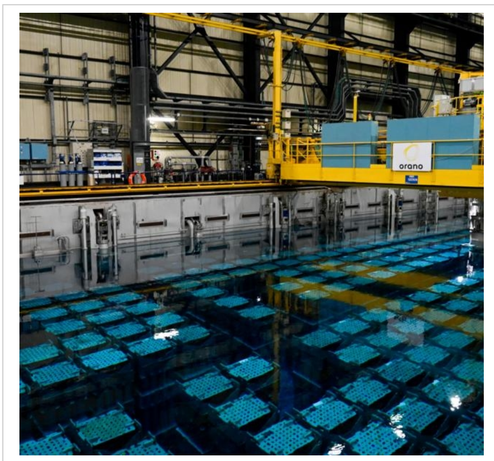
Les piscines d'Orano, à La Hague (Manche), risquent la saturation. © Martin Roche, Archives Ouest-France
